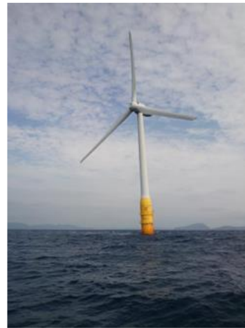
遠藤市長が 視察した長崎 県五島市の浮 体式洋上風力 発電施設(令 和3年10月)
